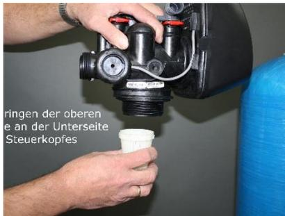
Lösen Sie den Abwasserschlauch vom Steuerkopf und gegebenenfalls eine bereits hergestellte Verbindung mit der Wasserleitung. Schrauben Sie den Steuerkopf vom Drucktank herunter. Mit dem Steuerkopf wurde die obere Düse geliefert. Nehmen Sie deren große Öffnung und stecken Sie diese in die große runde Öffnung an der Unterseite des Steuerkopfes. Mit einer Drehung im Gegenuhrzeigersinn wird diese Düse in der Öffnung des Steuerkopfes einrasten.
